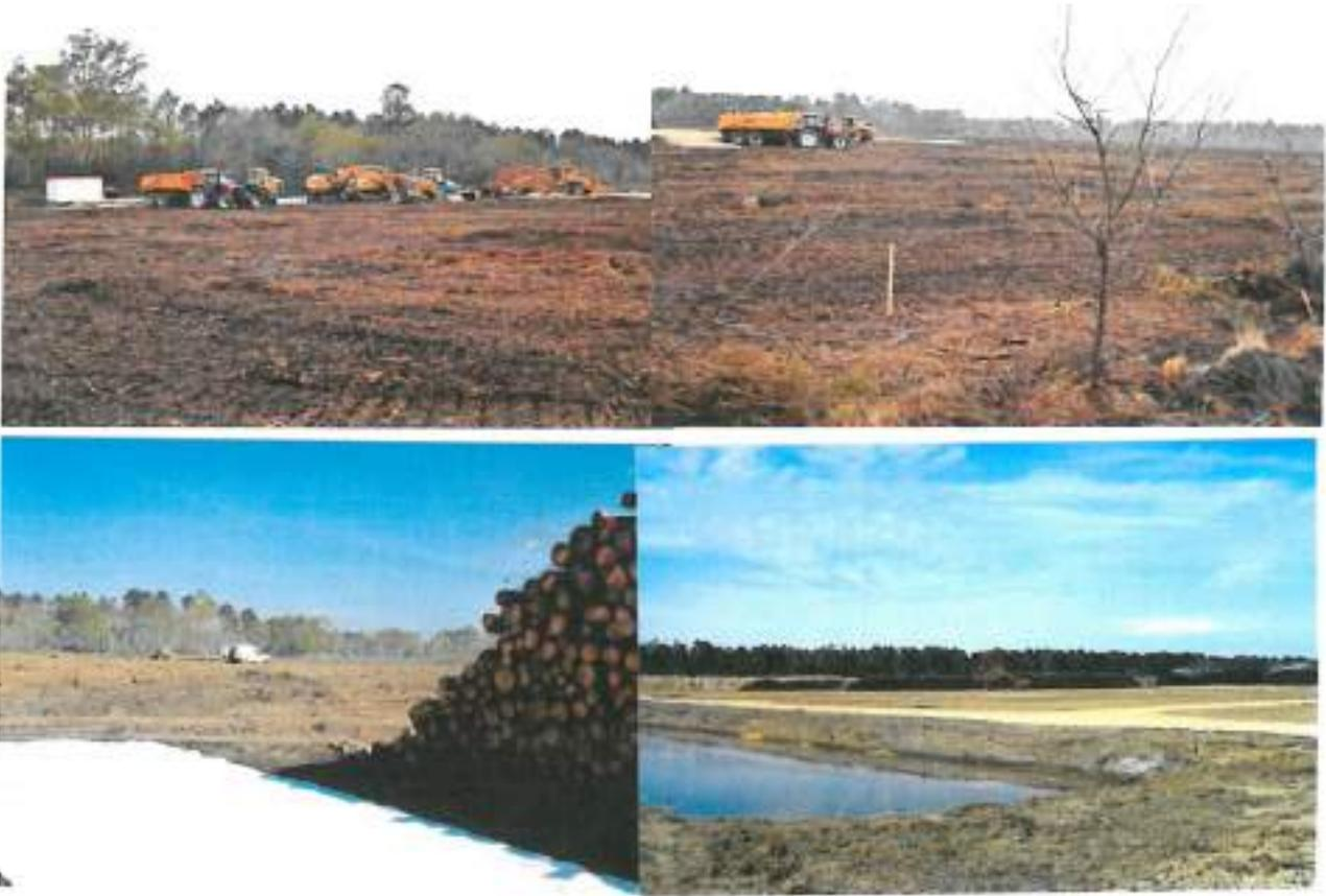
*Terrassement et préparation des infrastructures, pose de géotextile et préparation des pistes forestières, creusement des bassins de rétention d'eau et pose des drains d'assainissement sous les alvéoles de stockage de bois.*
