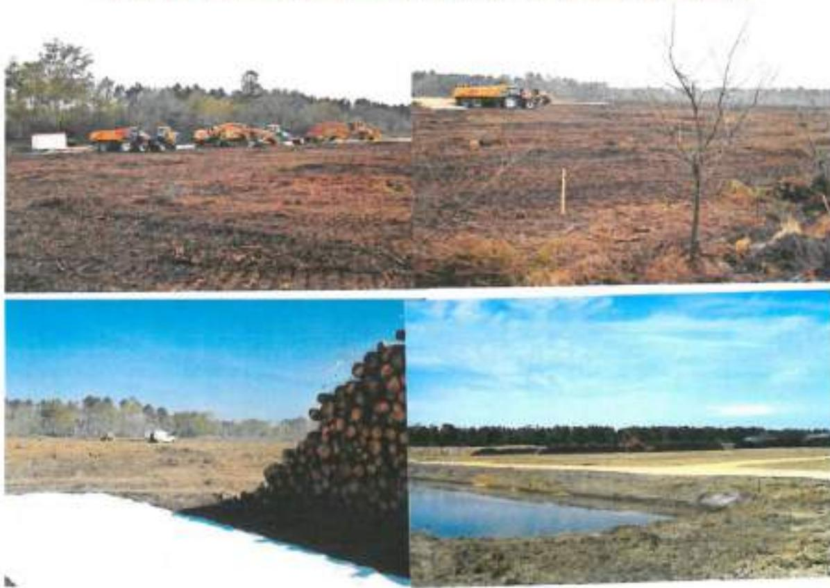
Travaux d'aménagement du site de la plateforme, suite à l'exploitation forestière. Terrassement et préparation des infrastructures, pose de géotextile et préparation des pistes forestières, creusement des bassins de rétention d'eau et pose des drains d'assainissement sous les alvéoles de stockage de bois.
