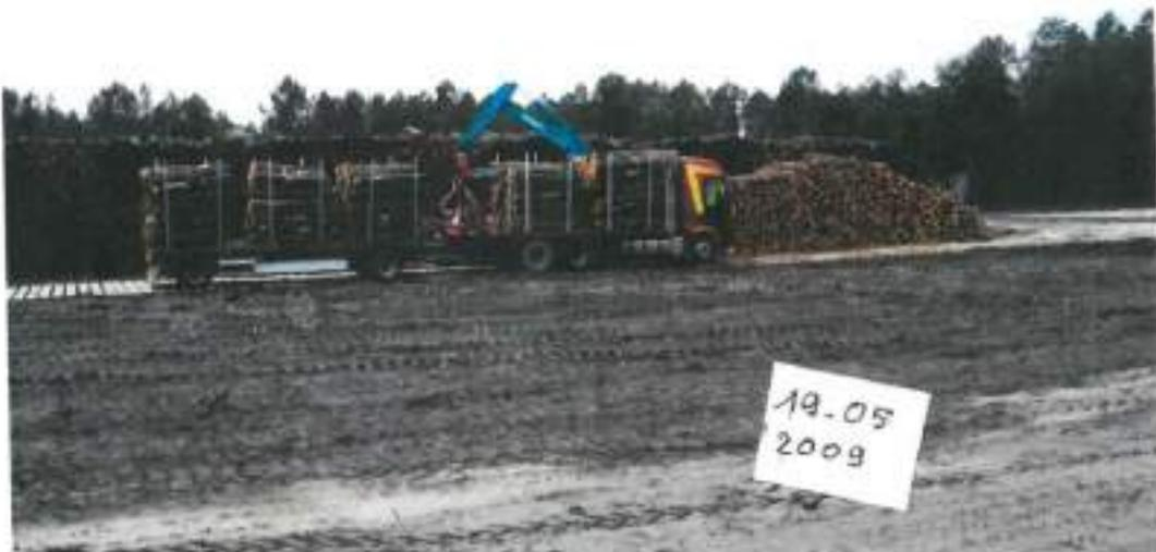
Important tassement du terrain, autant au niveau des alvéoles de stockage du fait de la quantité de bois stockée sur place, que sur les pistes de desserte de la plateforme. Ces terrains ont de plus subi un lessivage important lors de la période d'exploitation de la plateforme de stockage.
